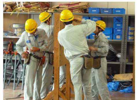
2年生実習（電気工事実習）
